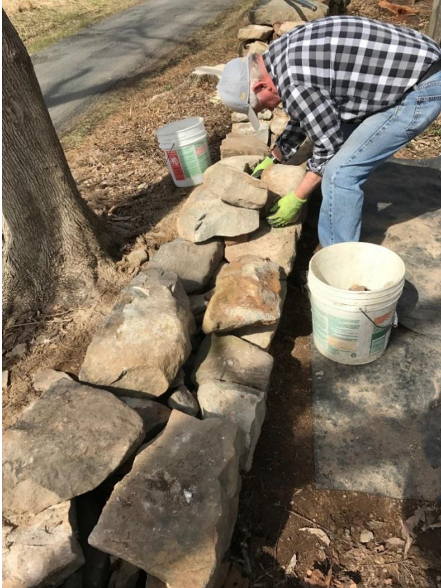
Dave Vorhees lays a stone
